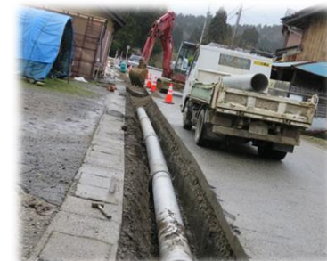
仮設の水道配管工事 (送水管の延長)
