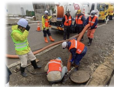
下水道管内の清掃
