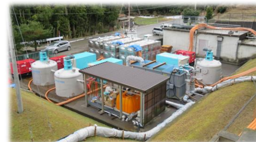
仮設の設備工事 (珠州市・宝立浄水場の機能回復)
