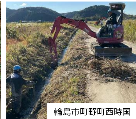
【水路啓開状況】
