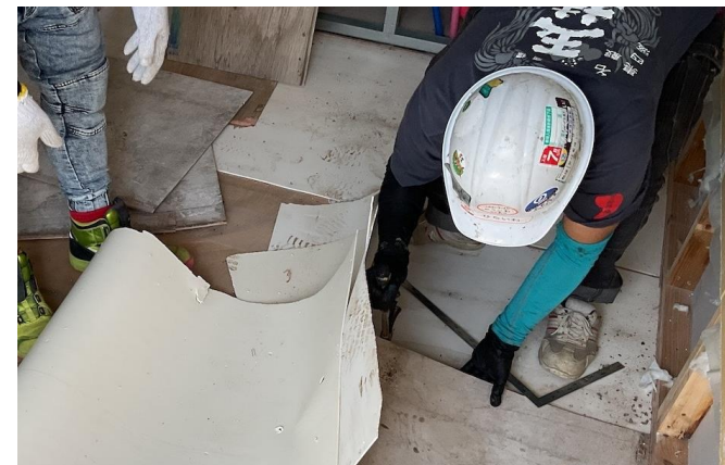
床の張替え状況
