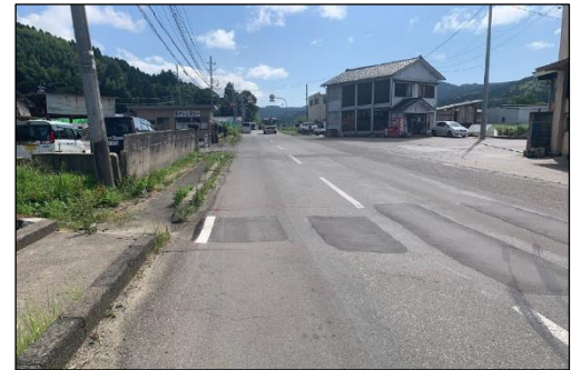
◇段差解消 (国道249号 輪島市稲屋町 地内)
