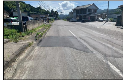
◇段差解消 (国道249号 輪島市稲屋町 地内)
