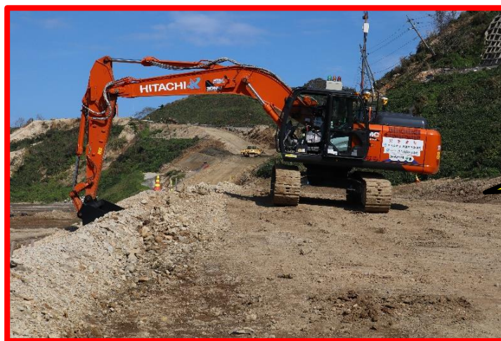
【遠隔操作される重機】
