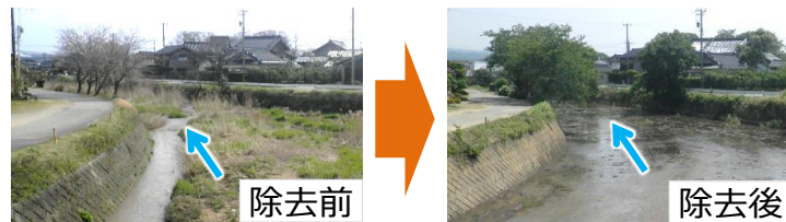
【堆積土砂除去例】前田川（宝達志水町）
