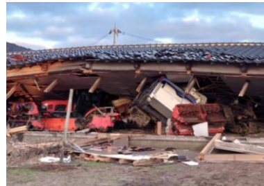
農機格納庫倒壊、農業機械破損
