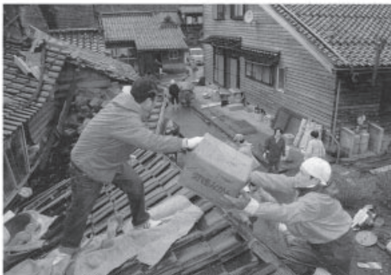
親類やボランティア等の協力を得て、倒壊した範囲の荷物を片づける住民たち=31日午後、石川県輪島市門前町で（水口慎子撮影）
