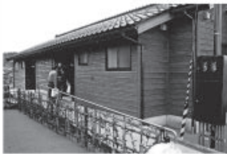
完成第1号となった災害公営住宅 ＝輪島市門前町道下
