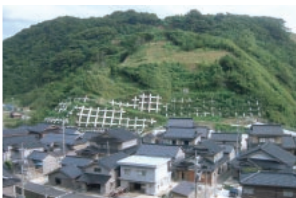
斜面の復旧状況=平成20年8月22日、輪島市門前町深見地区
