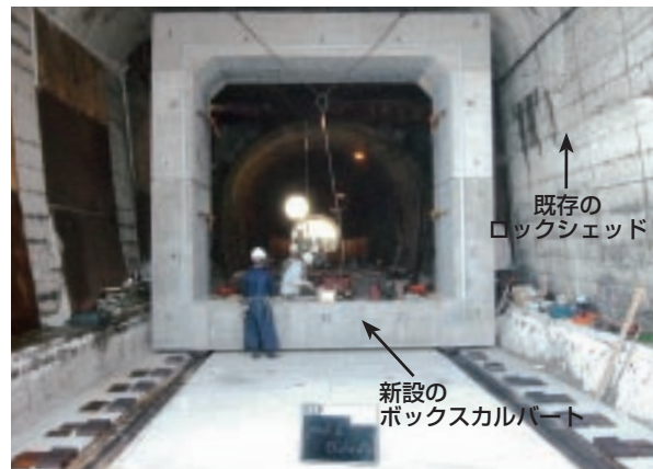
応急復旧により、新設ボックスを挿入(八世乃洞門)
