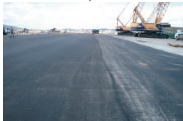
応急復旧状況=4月27日、七尾港
