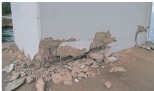
橋脚根元の被災状況 能登島大橋(七尾能登島公園線)
