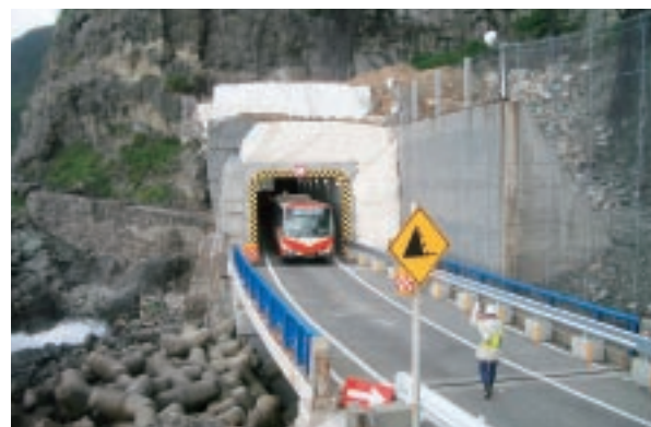
応急復旧により、通行を再開=7月7日、八世乃洞門の輪島側坑口
