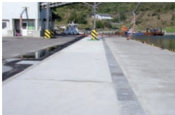
応急仮工事でエプロン段差解消＝4月下旬、輪島市門前町の鹿磯漁港
