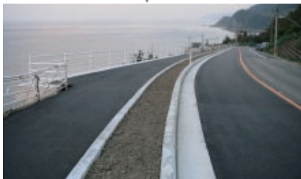
復旧状況 同上=10月25日
