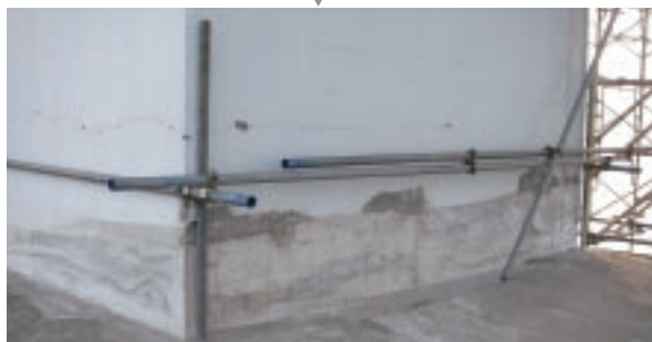
応急復旧状況 同上
