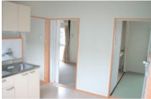
仮設住宅室内の段差解消状況
