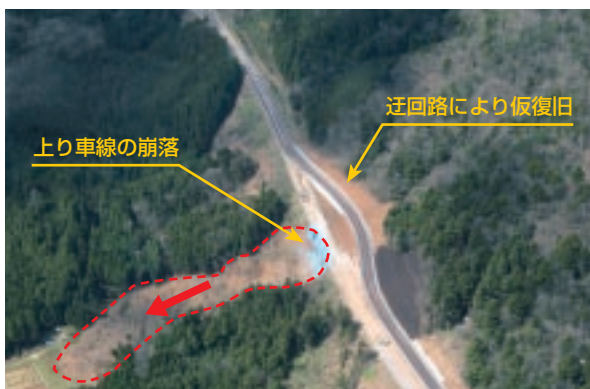
応急復旧状況 七尾市中島町(能登有料道路)
