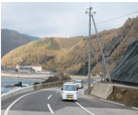
11月25日に復旧し、住民が順次、完全帰宅を果たした＝輪島市門前町深見
