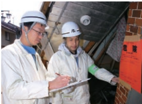
被災建物の応急危険度を判定
