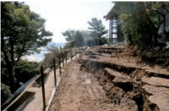
崩壊した斜面＝平成19年3月26日、鹿磯地区
