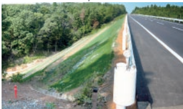
復旧状況 同上
