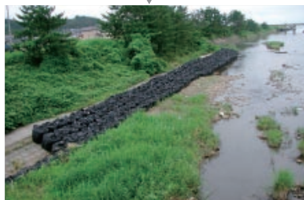
大型土のうによる応急復旧状況=7月13日
