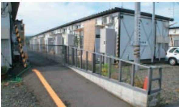
能登半島地震応急仮設住宅＝輪島市山岸町
