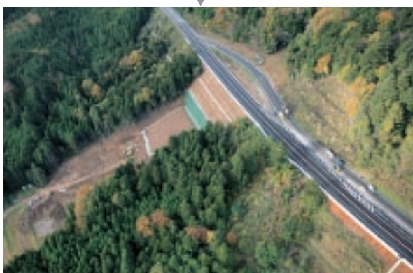
本復旧後 同上
