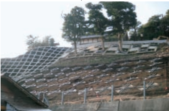
復旧状況＝平成20年2月21日、鹿磯地区
