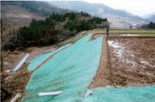
復旧工事が行われた山あいの棚田＝輪島市門前町小山
