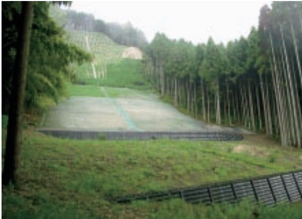
土留工・法枠工などによる復旧後＝平成20年7月31日
