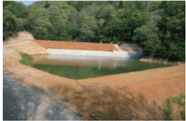
復旧状況 同上
