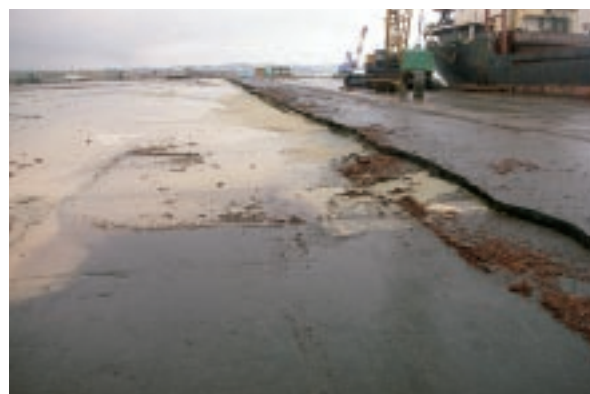
岸壁とふ頭用地の間に発生した段差=3月27日、七尾港
