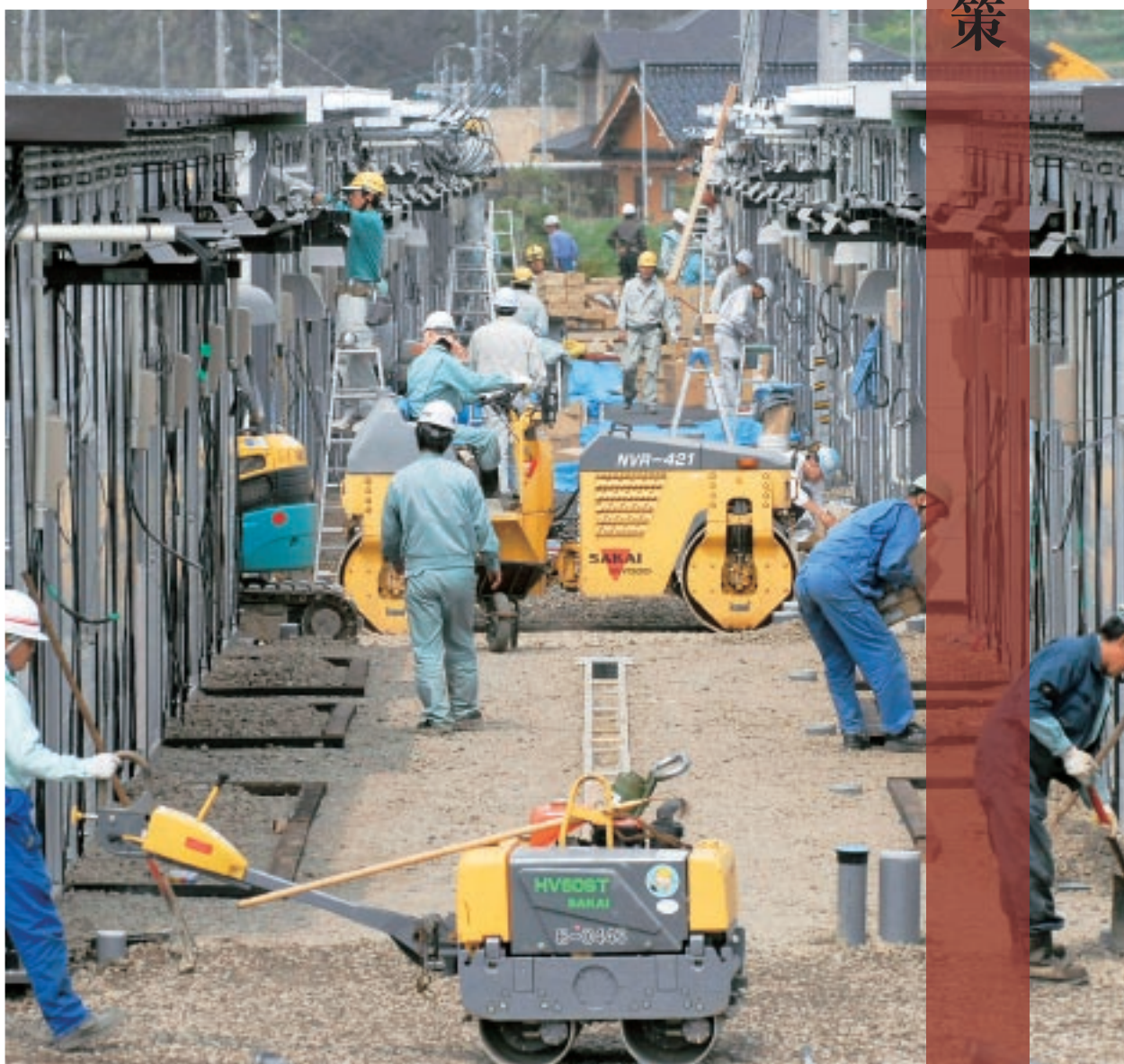
急ピッチで建設作業が進められた仮設住宅＝4月、輪島市門前町道下
