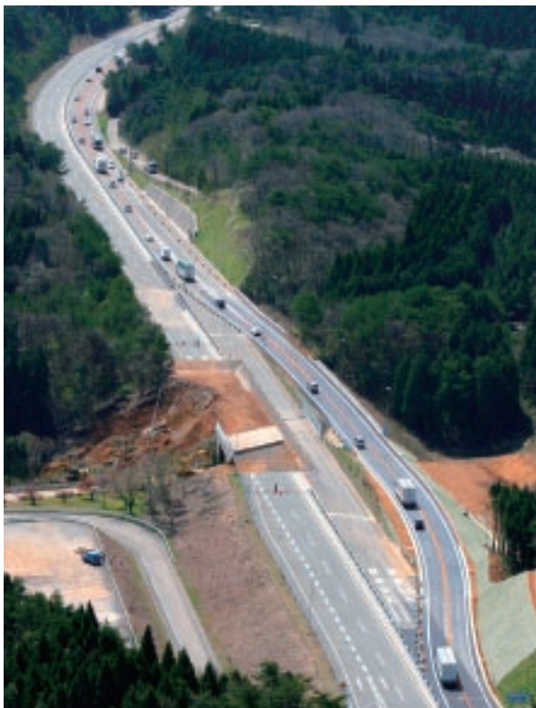
迂回路を設置し、全線で通行可能となった能登有料道路別所岳サービシアリア付近=4月27日
