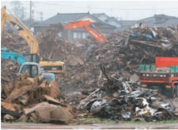
本格的に始まった解体ごみの分別作業＝6月25日、輪島市のマリンタウン
