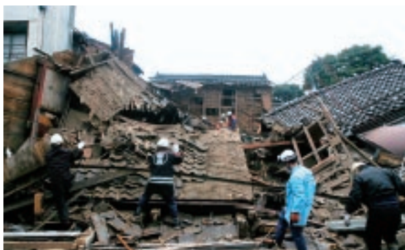
倒壊した家屋を調べる消防隊員＝3月25日、輪島市河井町
