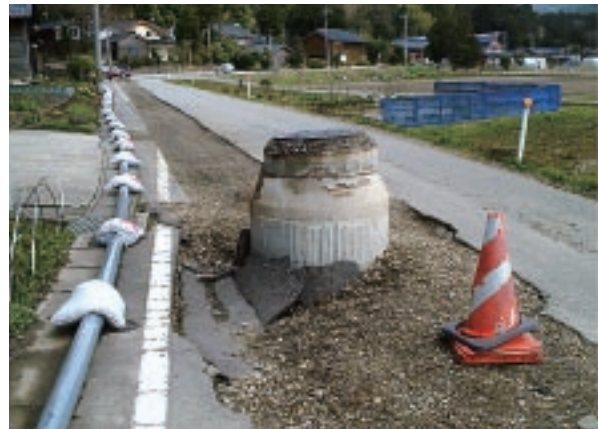
仮ポンプ・配管による流下不能箇所のバイパス
