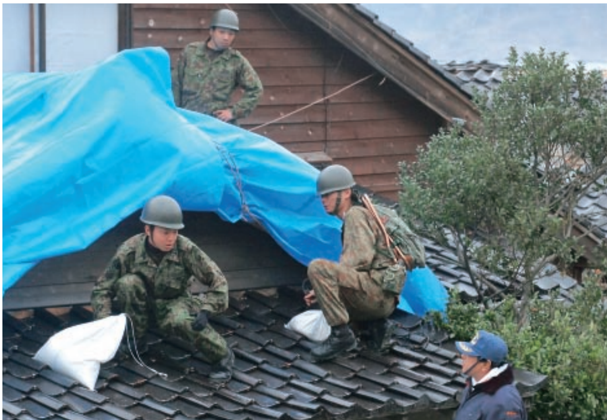
高齢者の多い輪島市門前町黒島町地区では自衛隊員が壊れた屋根にシートをかぶせた= 3月27日
