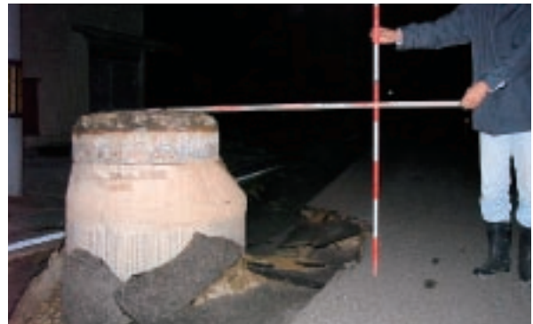
地震の影響で、約90cm以上も隆起したマンホール＝輪島市門前町(同市提供)
