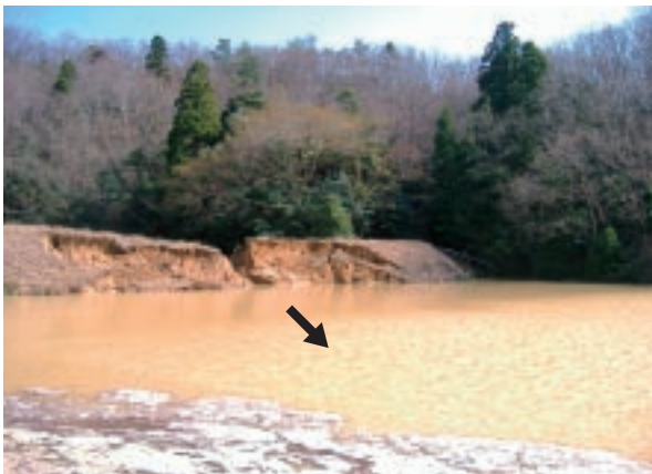
堤体下流側の法面崩落及び決壊＝3月27日、志賀町笹波の平田下池
