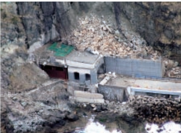
国道249号の八世乃洞門=4月5日
