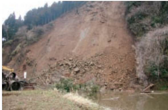
土砂でふさがれた輪島市熊野町の二級河川河原田川＝3月25日
