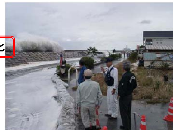
事例② 土のう積み
